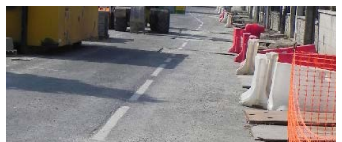
Travaux de voirie
