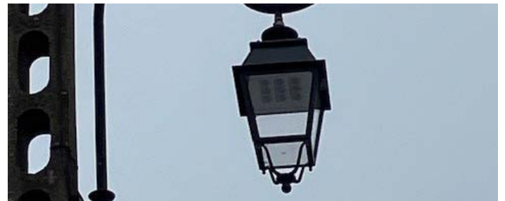
Passage en LED de l'éclairage public
