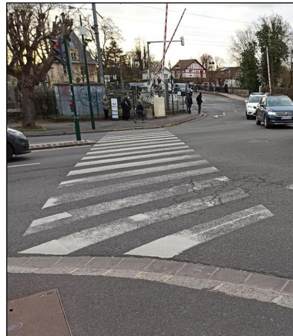
Traversée piétonne sur la branche Rue R. Poincaré (D4 Nord)
