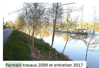
Parmain travaux 2009 et entretien 2017
