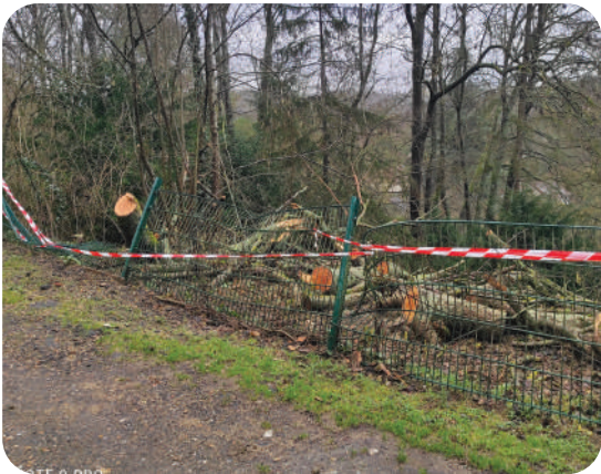
Mars - Réparation et extension du grillage à l'entrée du cimetière de Jouy-le-Comte
