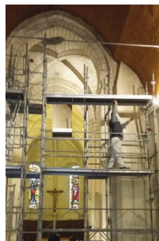
Chantier en cours
