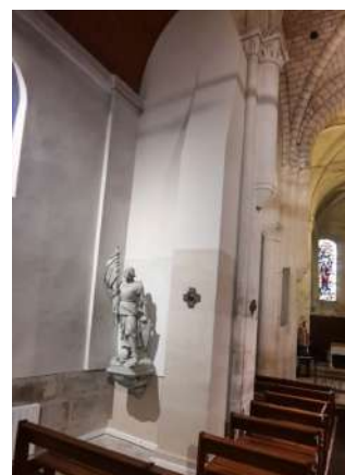
Mur de la Nef
