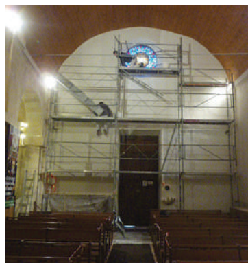
Chantier en cours
