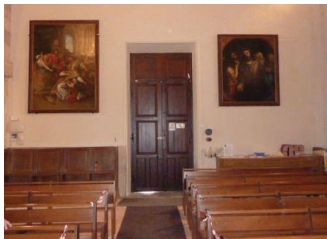
Mur terminé, tableaux remis en place
