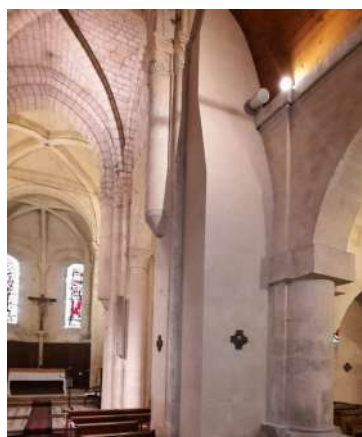
Mur de la Nef
