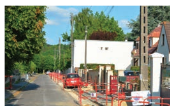
Travaux de voirie
