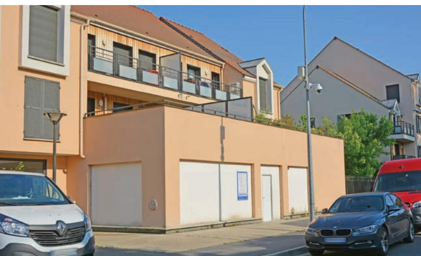
Emplacement de la future crèche
